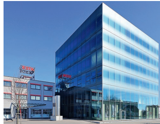
ESTA Apparatebau GmbH & Co. KG, Senden
